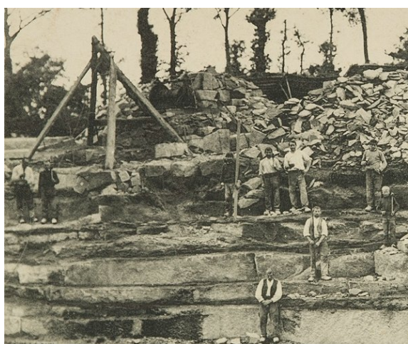
Figure 5: Une carrière de granite. A gauche, une chèvre à quatre pieds, des ouvriers avec leurs outils (masse, barre à mines...). Coll. Musée Bret., extrait de « Saint-Marc-le-Blanc carrière de la Vallée Olive ». Domaine public.
